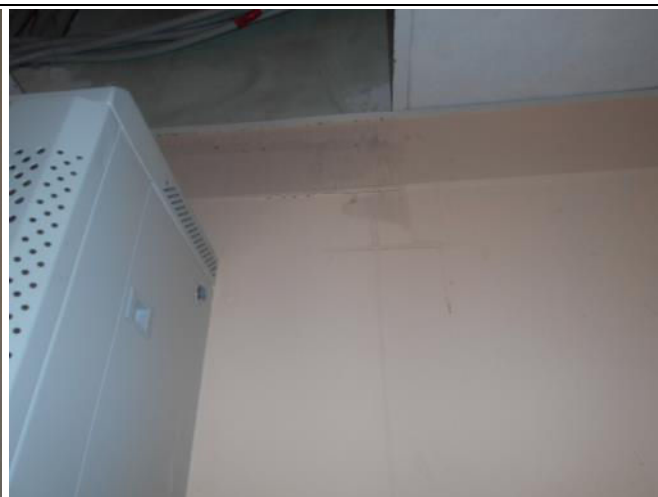
Фотография 3.14. Состояние отделки помещений (помещение №5)
