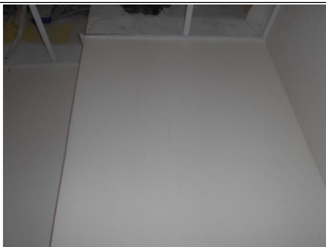
Фотография 3.19. Состояние отделки помещений (помещение №10)
