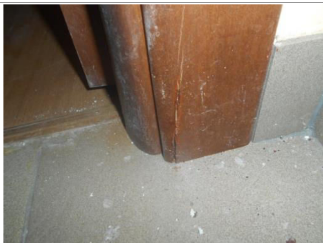
Фотография 3.22. Состояние отделки помещений (дверные блоки) Состояние мебели
