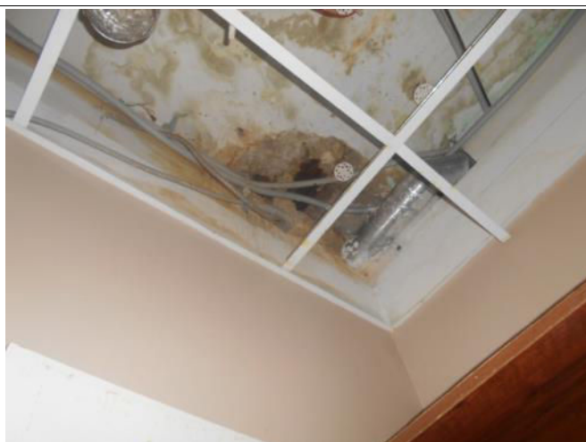
Фотография 3.23. Состояние отделки помещений (помещение №6)
