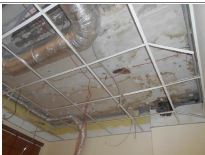
Фотография 3.17. Состояние отделки помещений (помещение №10)
