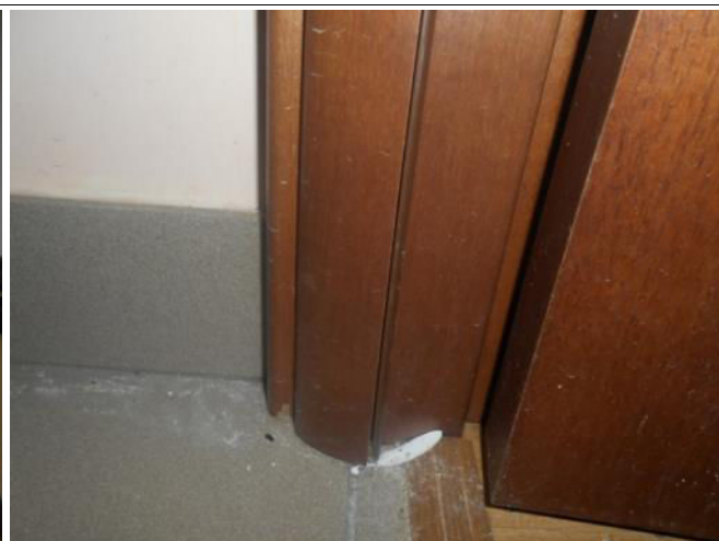
Фотография 3.16. Состояние отделки помещений (дверные блоки)
