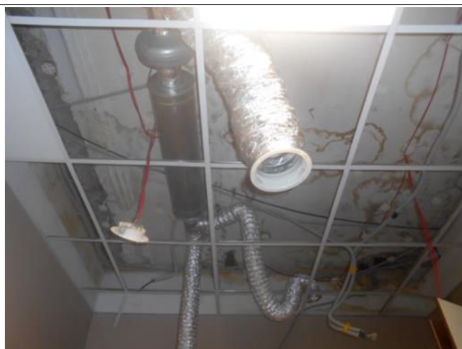
Фотография 3.24. Состояние отделки помещений (помещение №6)
